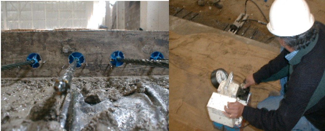
Fig.4.8 Cables de pretensado, recién hormigonado Fig.4.9 Tensado inicial de cables
